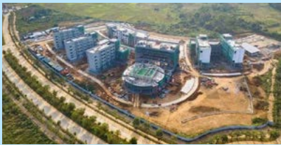
Công trình Trường ĐH Công nghệ 35,000m 2 sàn
