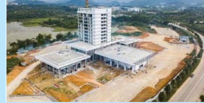
Công trình Tòa nhà trung tâm điều hành với hơn 13.000m 2 sàn
