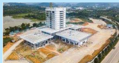
Công trình Tòa nhà trung tâm điều hành với hơn 13.000m 2 sàn
