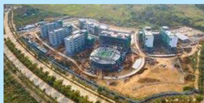
Công trình Trường ĐH Công nghệ 35,000m 2 sàn
